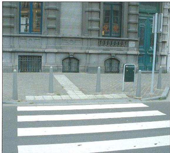
Dans les cas particuliers des traversées dans des courbes, une partie des dalles à protubérances se situe en dehors du trottoir. Il est alors nécessaire d'effectuer les modifications suivantes.
