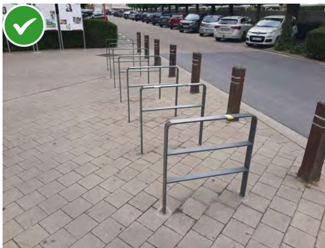
Arceaux pour vélos installés sur le trottoir : le 1 er et le dernier arceau sont équipés d'une 3 e barre horizontale
