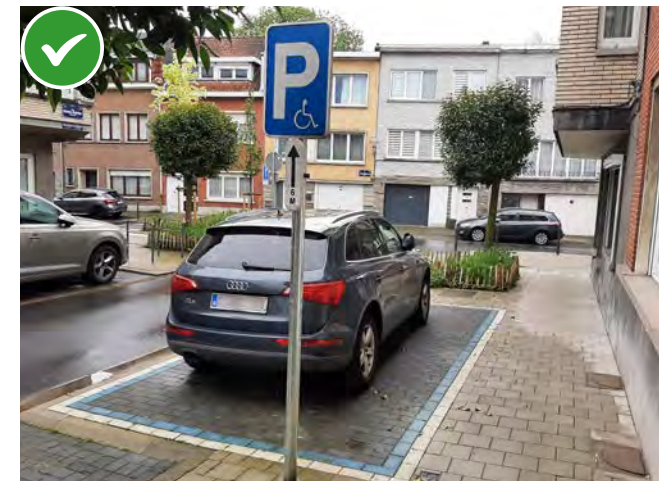
Stationnement pleinement accessible. Pour remarque, la largeur résiduelle correspond à celle du trottoir qui est néanmoins inférieure au minimum de 2 m
