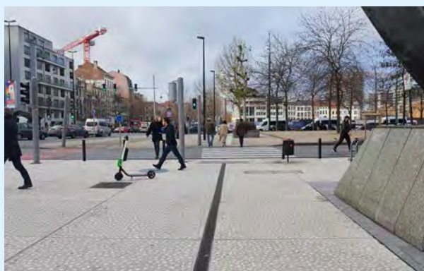
Exemple de différents dispositifs de guidage/repérage installés dans l'espace public (bordure 4/16, filets d'eau) Source: Atingo
