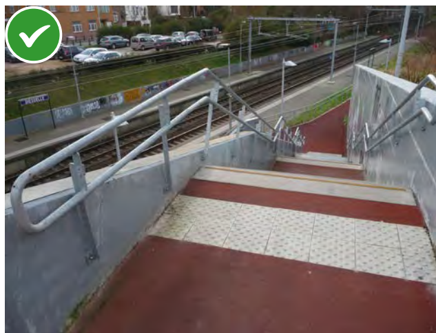
Installation des revêtements à protubérances en haut et en bas des escaliers hors palier(s) intermédiaire(s)
