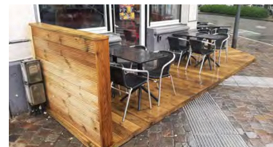
Terrasse attenante à la façade, détectable sur son pourtour pour une personne déficiente visuelle. L'accessibilité de plain-pied vers la terrasse n'est cependant pas assurée
