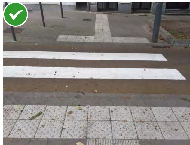
Marquage podotactile installé de part et d'autre de la piste cyclable
