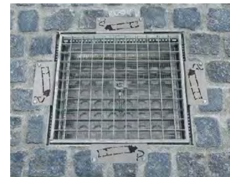
Les cendriers de sol présentent généralement des ouvertures > 2 cm et doivent dans ce cas être installés hors des cheminements piétons
