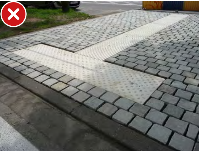
Le revêtement est aligné sur le sommet des stries et protubérances qui ne ressortent donc pas du revêtement
