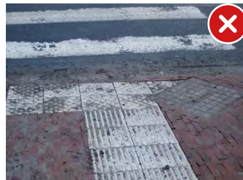
La chambre de visite interrompt le signal de danger matérialisé par les dalles à protubérances !
