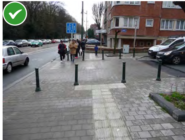
Trottoir traversant correctement aménagé
