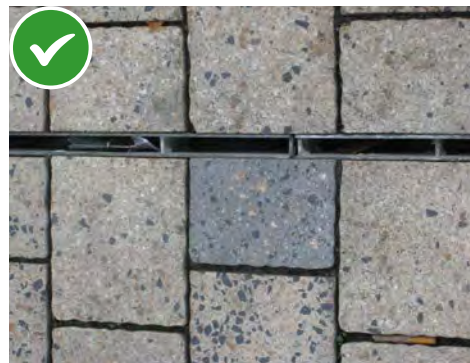
Caniveau à fente (max 2 cm)
