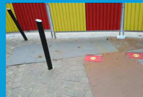
Revêtements podotactiles neutralisés temporairement par des plaques métalliques pendant un chantier
