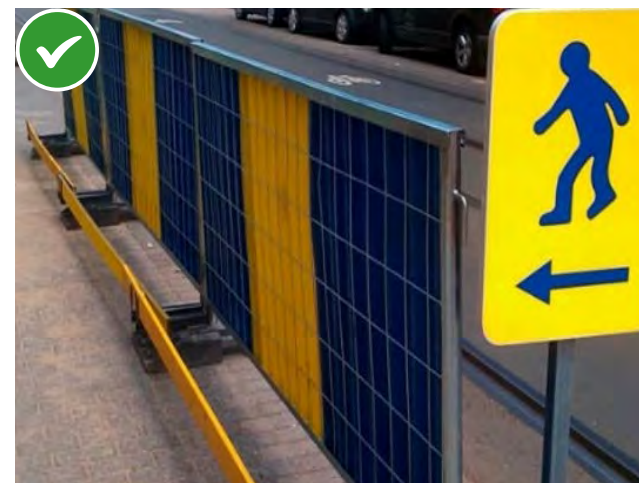
La lisse peut être attenante à la barrière à condition que les socles de fixation n'empiètent pas sur le cheminement
