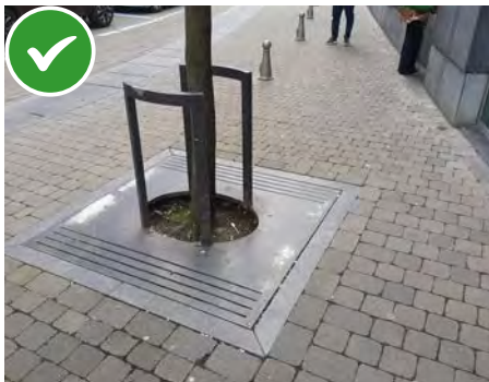
Grille de protection accessible permettant de dégager un libre passage de 2 m depuis la façade
