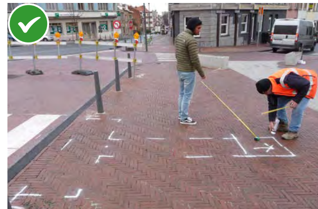
Tracer les revêtements podotactiles au sol avant d'effectuer les découpes
