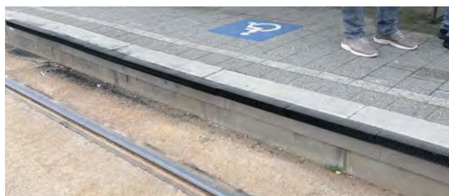
Le nez-fusible supprime la lacune horizontale entre le quai et le tram
