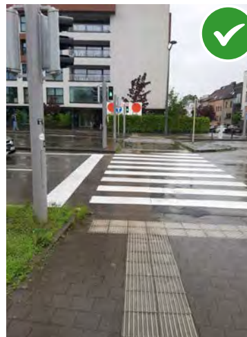
Feux sonores alignés de part et d'autre des traversées et situés à proximité immédiate des revêtements podotactiles placés sur toute la largeur de la traversée
