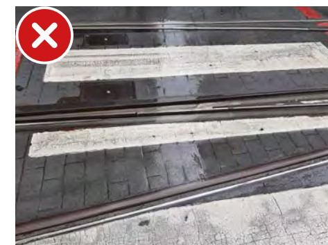
Pointe d'aiguillage située dans une traversée piétonne
