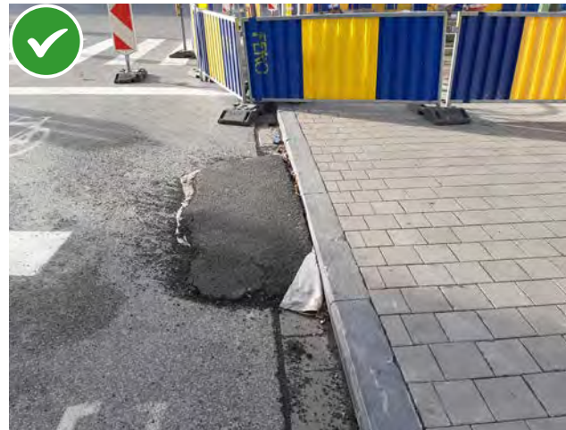
Rampe provisoire installée lors d'un chantier pour permettre le franchissement d'une bordure
