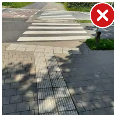
Les dalles striées ne sont pas perpendiculaires aux dalles à protubérances et n'indiquent pas l'axe du passage piéton
