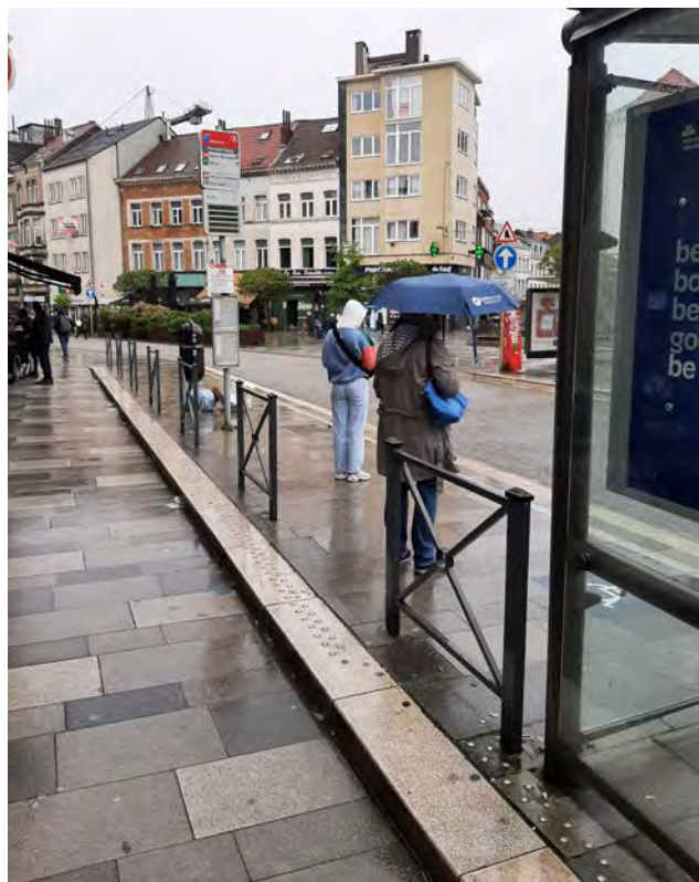
Différence de niveau verticale entre le quai et le trottoir signalée par des barrières installées à intervalles réguliers
