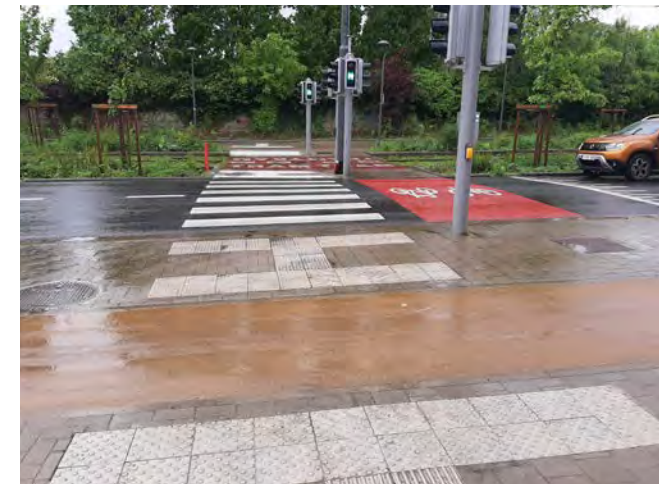
Feux cyclo-piétons alignés et installés entre la traversée piétonne et cycliste (attention : le marquage blanc de la traversée piétonne sur la piste cyclable doit encore être réalisé)
