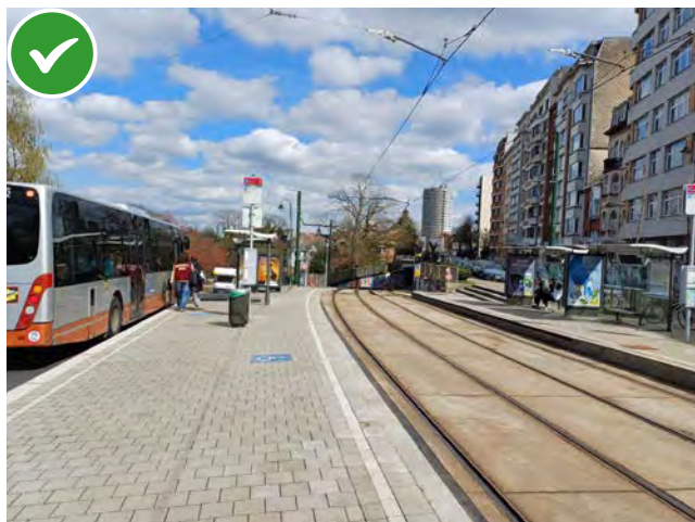
Arrêt mixte tram-bus avec une hauteur des quais adaptée selon le type de véhicule
