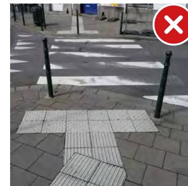
Le changement de direction des revêtements striés n'est pas matérialisé par des dalles souples, la ligne de guidage est trop courte (< 1 m 20) et des potelets sont présents dans l'axe des striés...
