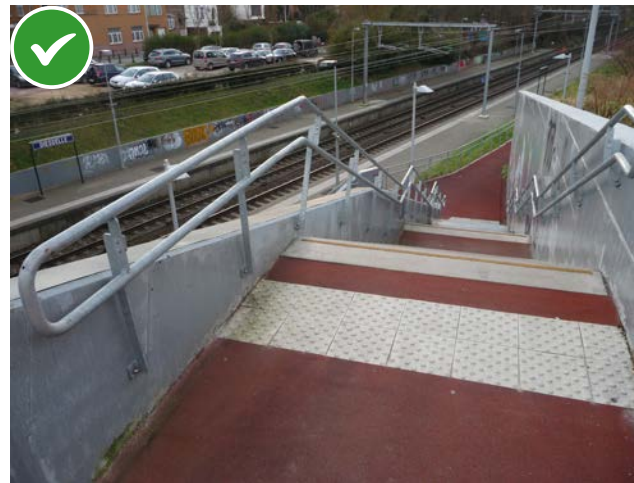
Installatie van noppentegels bovenaan en onderaan de trappen behalve op het/de tussenbordes(sen)
