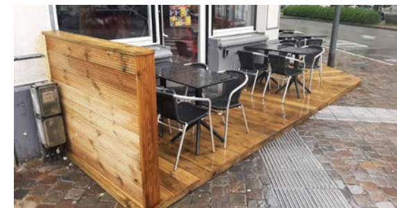
Terras grenzend aan de gevel, detecteerbaar over de omtrek ervan voor een slechtziende. Een toegang tot het terras zonder niveauverschil is echter niet gegarandeerd
