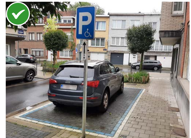
Volledig toegankelijke parkeerplaats. Hierbij dient opgemerkt dat de restbreedte overeenkomt met die van het trottoir, wat toch minder is dan de minimumbreedte van 2 m
