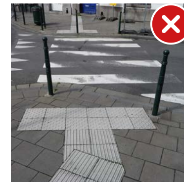
De verandering van richting van de ribbeltegels wordt niet gematerialiseerd door soepele tegels, de geleidelijn is te kort (< 1,20 m) en er zijn paaltjes aanwezig in de as van de ribbels ...
