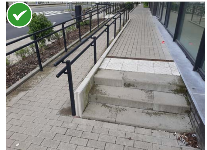
Installatie van noppentegels alleen bovenaan de treden voor een trap zonder bordes geïnstalleerd in een openbare ruimte.
