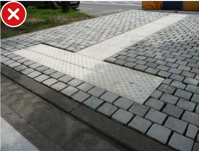
De verharding wordt uitgelijnd met de bovenkant van de ribbels en noppen die dus niet uit de verharding uitsteken
