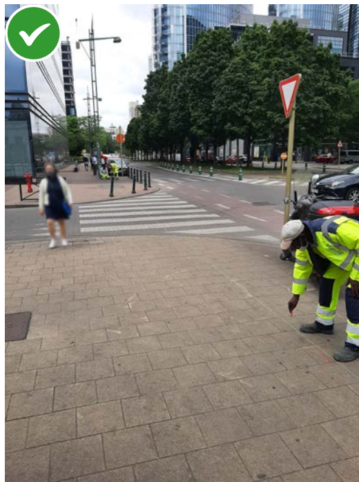
Gebruik een touwtje om de as van de oversteekplaats op de grond te tekenen
