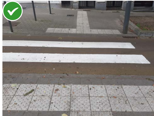
Podotactiele marking aan beide zijden van het fietspad aangebracht
