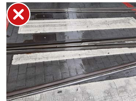
Puntstuk van een tramwissel in een oversteekplaats voor voetgangers
