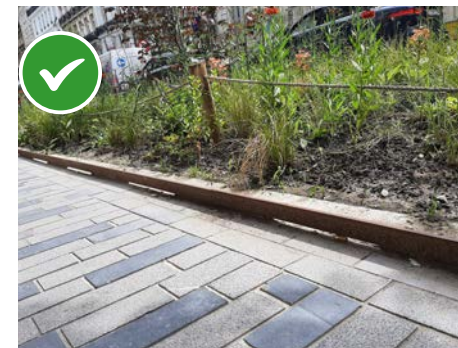
Voorbeeld van een opengewerkte boordsteen
