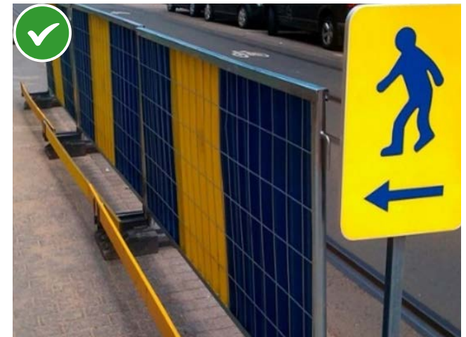
De stang kan zich naast de afsluiting bevinden, op voorwaarde dat de bevestigingssokkels niet op de looproute komen
