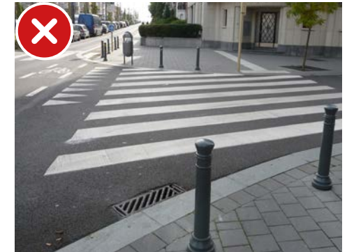
Rioolkolk geplaatst op de oversteekplaats voor voetgangers
