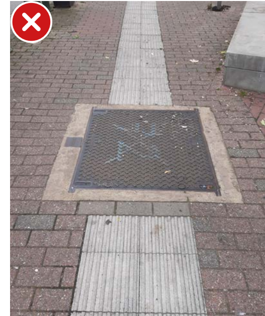
De podotactiele geleiding mag niet onderbroken worden
