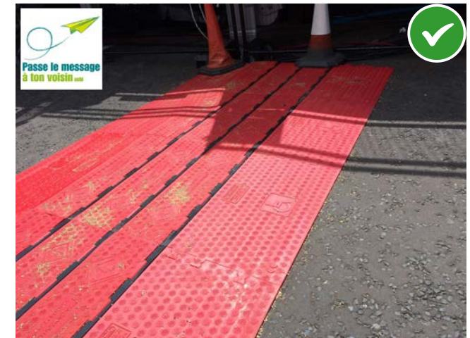
Voorbeeld van een kabelgoot die voldoet aan de toegankelijkheidscriteria
