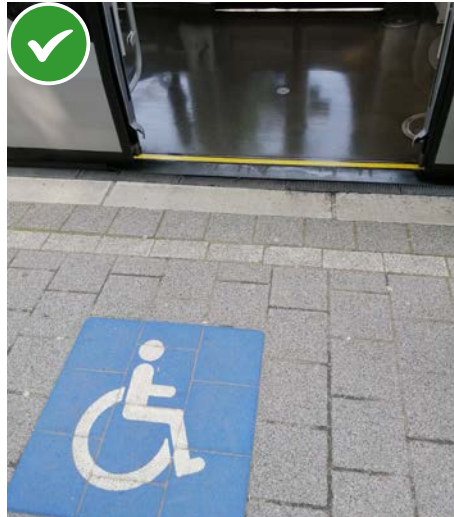
Blauwe tegel ter hoogte van de 2 e deur van het rijtuig, ter aanduiding van de instapzone voor rolstoelgebruikers
