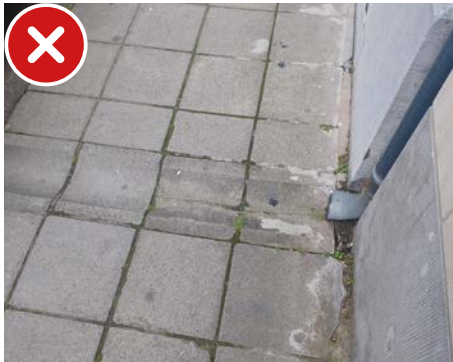
Holronde afvoergoten moeten vermeden worden
