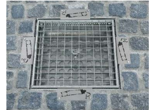
Vloerasbakken hebben over het algemeen openingen > 2 cm en moeten daarom buiten voetpaden worden geïnstalleerd
