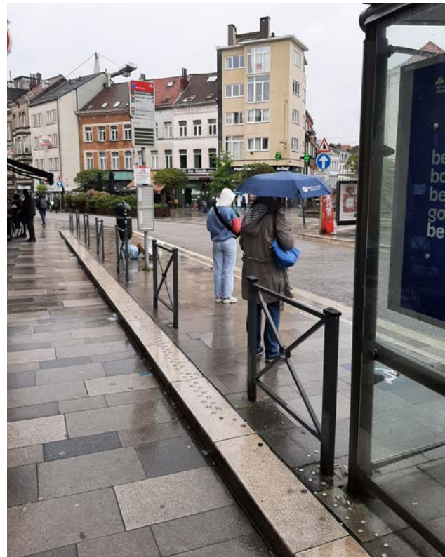
Verticaal niveauverschil tussen perron en trottoir aangegeven door op regelmatige afstanden geplaatste afsluitingen
