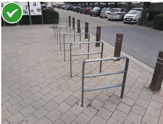
Fietsnietjes geplaatst op het voetpad: het eerste en laatste fietsnietje is voorzien van een 3 de horizontale stang
