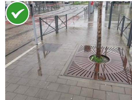
Beschermrooster dat geen obstakel vormt voor voetgangers
