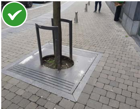
Toegankelijk beschermrooster dat een vrije doorgang van 2 m vanaf de gevel mogelijk maakt
