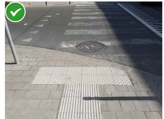
De eerste strook noppentegels is volledig
